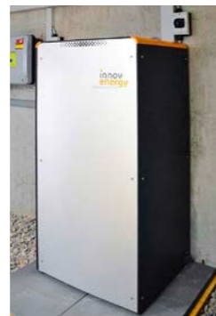
Innenansicht einer fertig installierten Salz-batterie. (Abb. 1)
