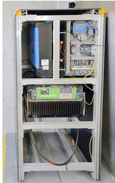
Innenansicht einer fertig installierten Salz-batterie. (Abb. 1)
